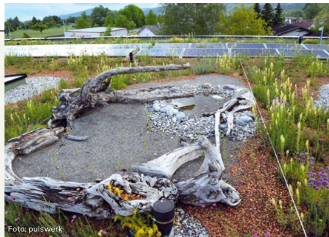
Foto: pulswerk Neubau eines Kindergartens in Hohenems auf dem Dach eines Lebensmittelgeschäftes.
